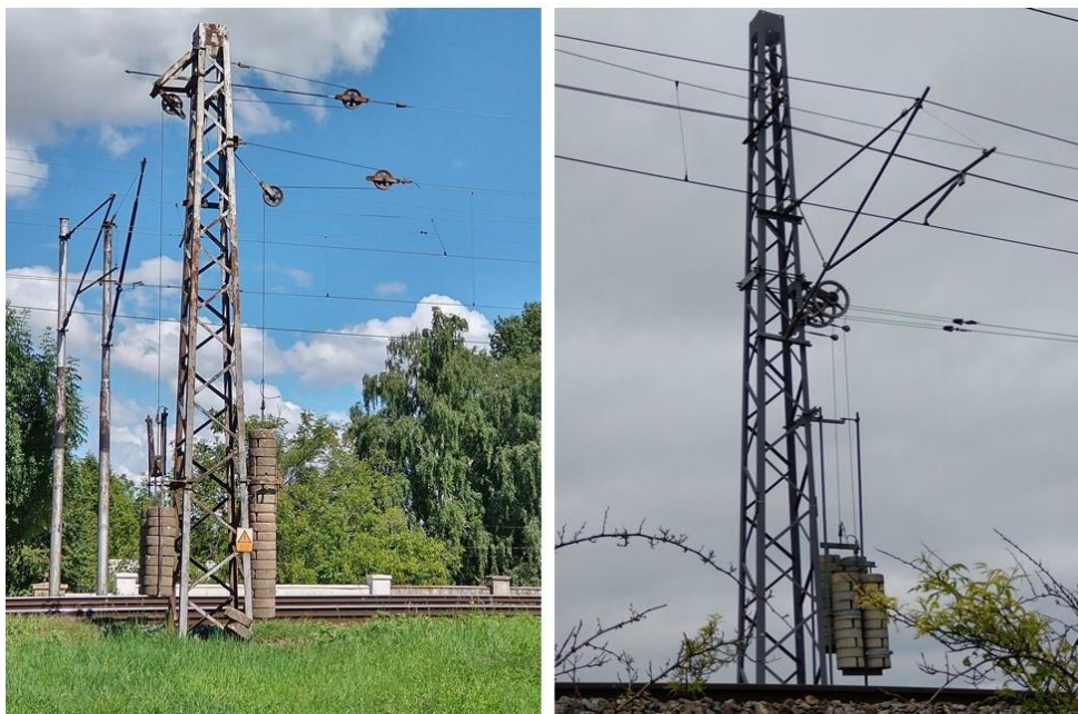
Obr. 15. Napínání troleje pomocí kladek nebo navijáku. V případě navijáku je trolej (resp. nosné lano) navinuta na menším kole navijáku, lano nesoucí závaží na větším kole. Větší kolo je navíc opatřeno zuby, které zapadnou do západky v případě, že by došlo k náhlému odlehčení lana (např. při prasknutí). V takovém případě je zabráněno pádu závaží.
