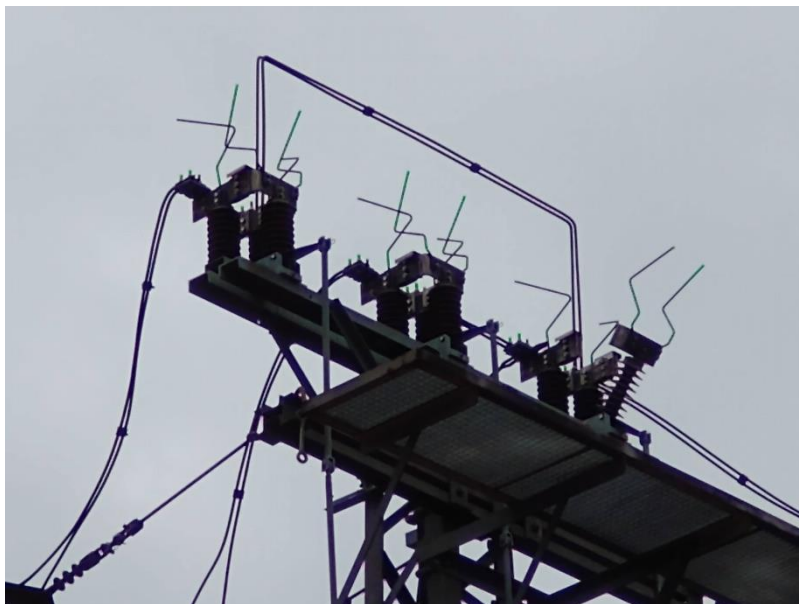
Obr. 8. Tři odpojovače na jednom stožáru. Pravý je rozepnut, levé dva jsou sepnuty.
