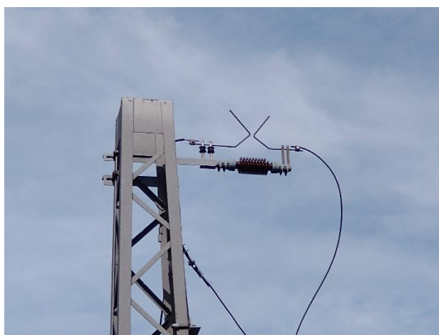
Obr. 3. Bleskojistka na stožáru nesoucím trolejové vedení. Levý růžek je uzemněn, vodič uchycený na pravý růžek vede k troleji. Oba růžky jsou odděleny izolátorem.
