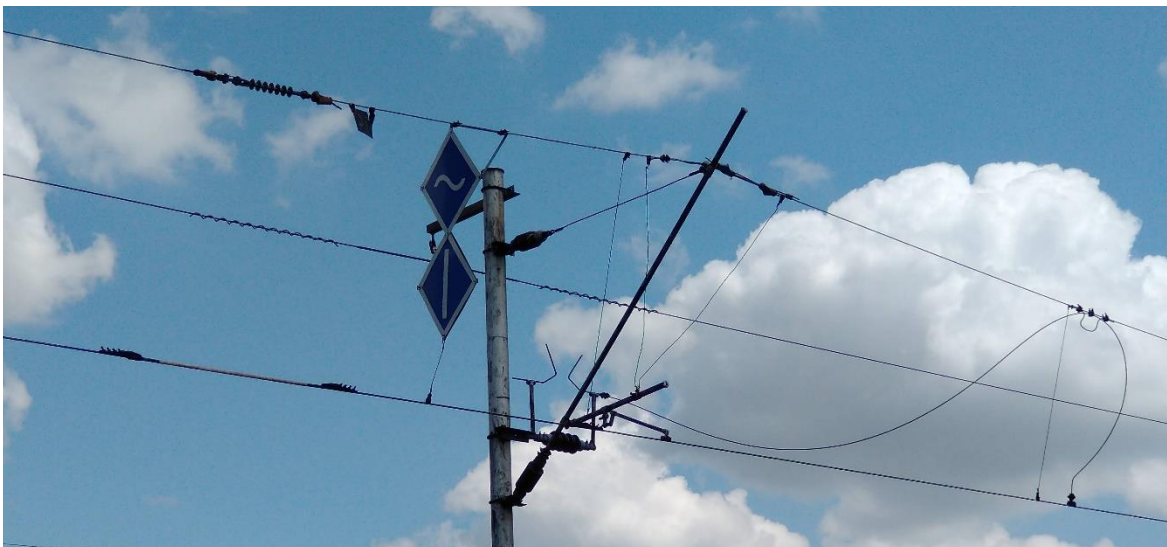
Obr. 14. Styk stejnosměrné a střídavé soustavy ve stanici Kutná Hora hl. n. Horní obr.: Stejnoseměrná trolej zleva je spojena s neutrálním polem izolační tyčí, nosné lano izolátorem. V levé části snímku je patrná bleskojistka, jeden růžek připojen k troleji, druhý uzemněn. Prostřední obr.: Neutrální a uzemněná část troleje je oddělena od obou okolních neutrálních polí izolačními tyčemi (v levé a pravé části snímku). Je patrné, že výložník nesoucí trolej je upevněn na stožár bez izolátorů. Je vidět i uzemňovací vodič spojující trolejový drát se stožárem (a po něm se zemí). Dolní obr.: Vlevo izolační tyč, doprava pokračuje střídavá trolej. Na stožáru patrná bleskojistka s výrazně vzdálenějšími růžky. Špičkové napětí mezi trolejí a zemí je zde cca 12 krát větší než na stejnosměrném systému.
