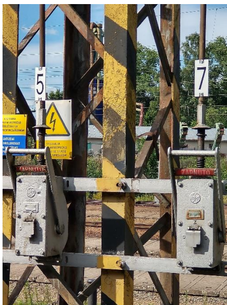
Obr. 9. Ovládání odpojovačů ze země pomocí páky a táhla.
