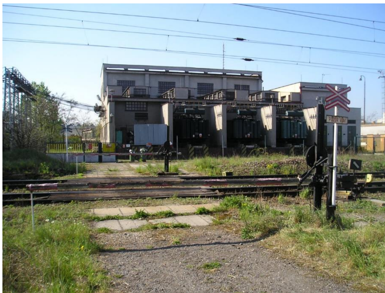
Obr. 5. Trakční měnírna (převzato z [1]).
